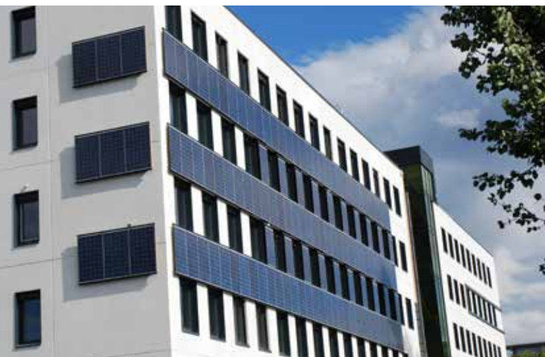
Energibyggget Lerkendal - nettilknyttet solcelleanlegg på 24 kW
